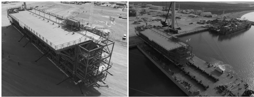
Fig. 2. Fasi di movimentazione: caricamento del modulo sulla bettolina
