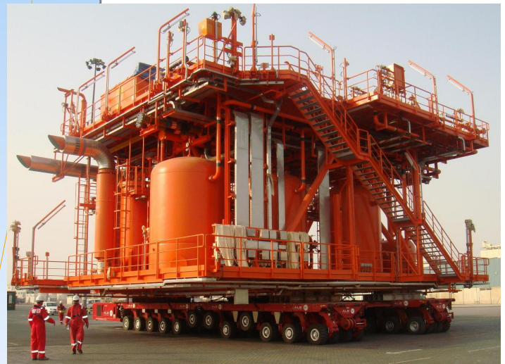
- Modulo T20 in fase di load-out
